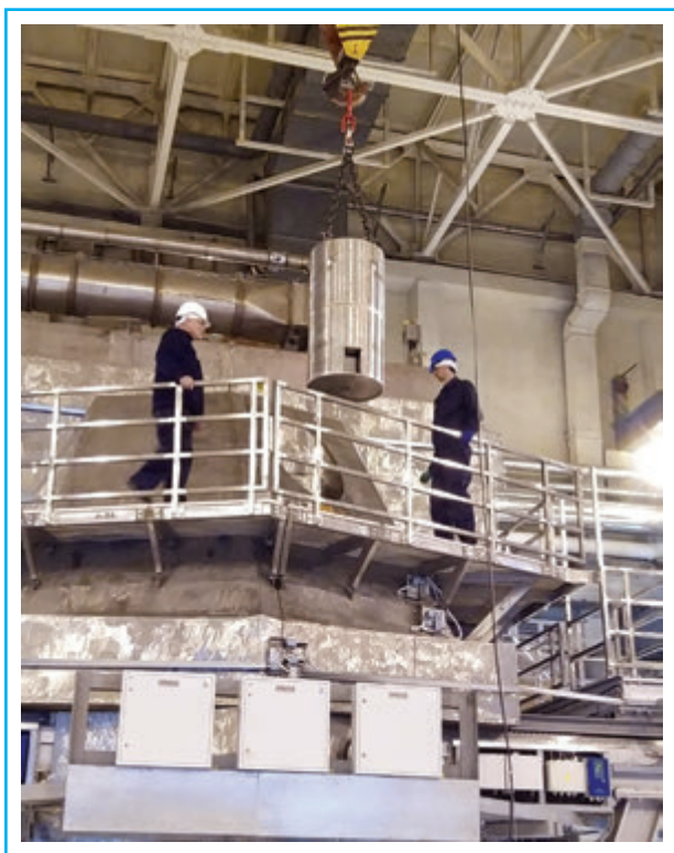
Будівля для ядерної підкритичної установки "Джерело нейтронів"
